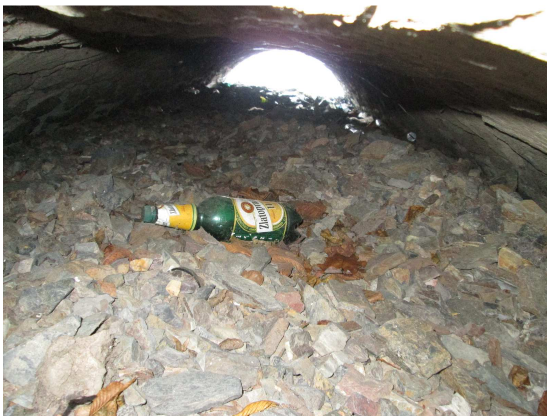
Mostní otvor zprava. Silné nánosy. Dtto.
