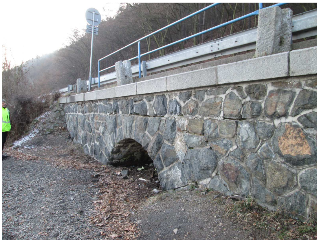
Pohled zleva. Čelní zed' částečně vykloněná. Poškození spárování.
