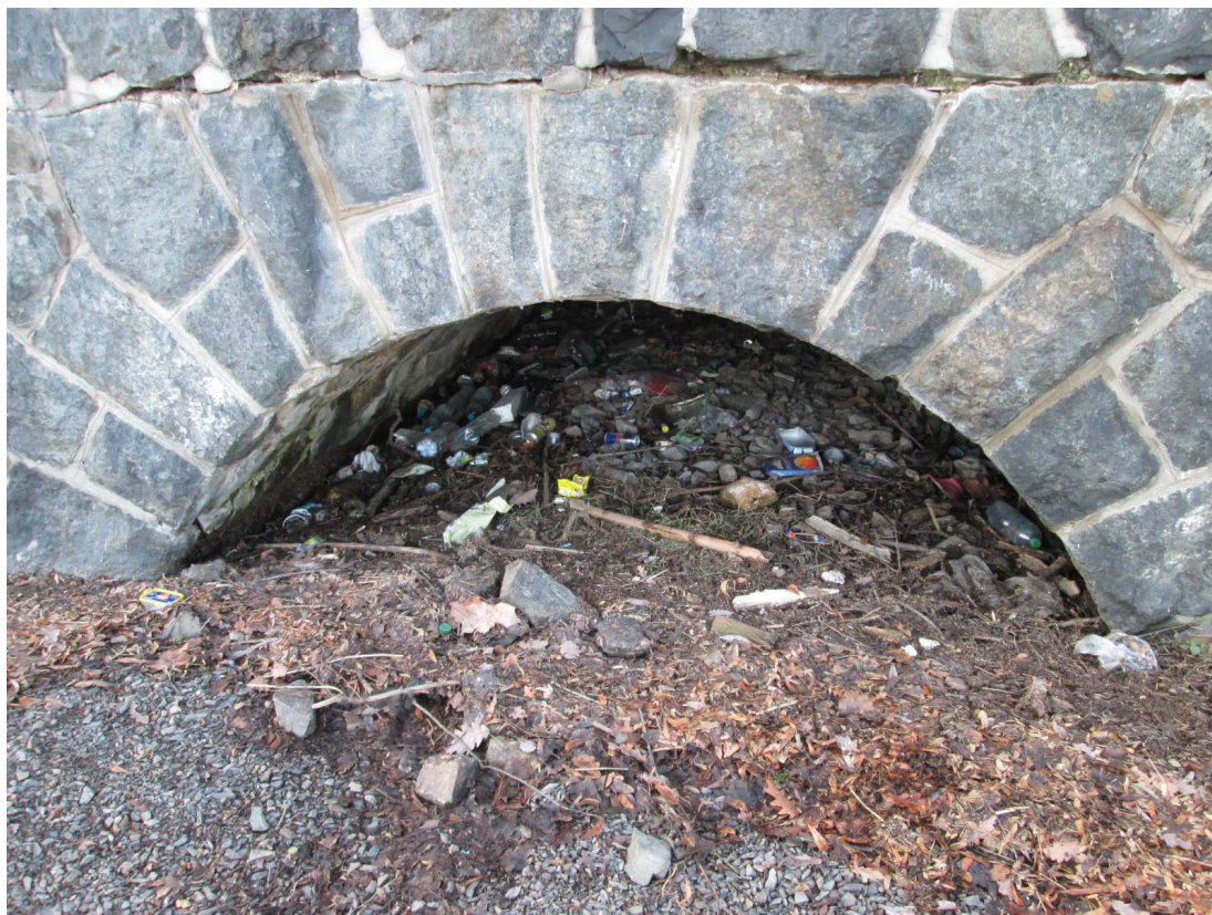
Mostní otvor zprava. Silné nánosy. Mostní otvor neprůchozí. Nevyhovuje pro převedení povodňových průtoků.
