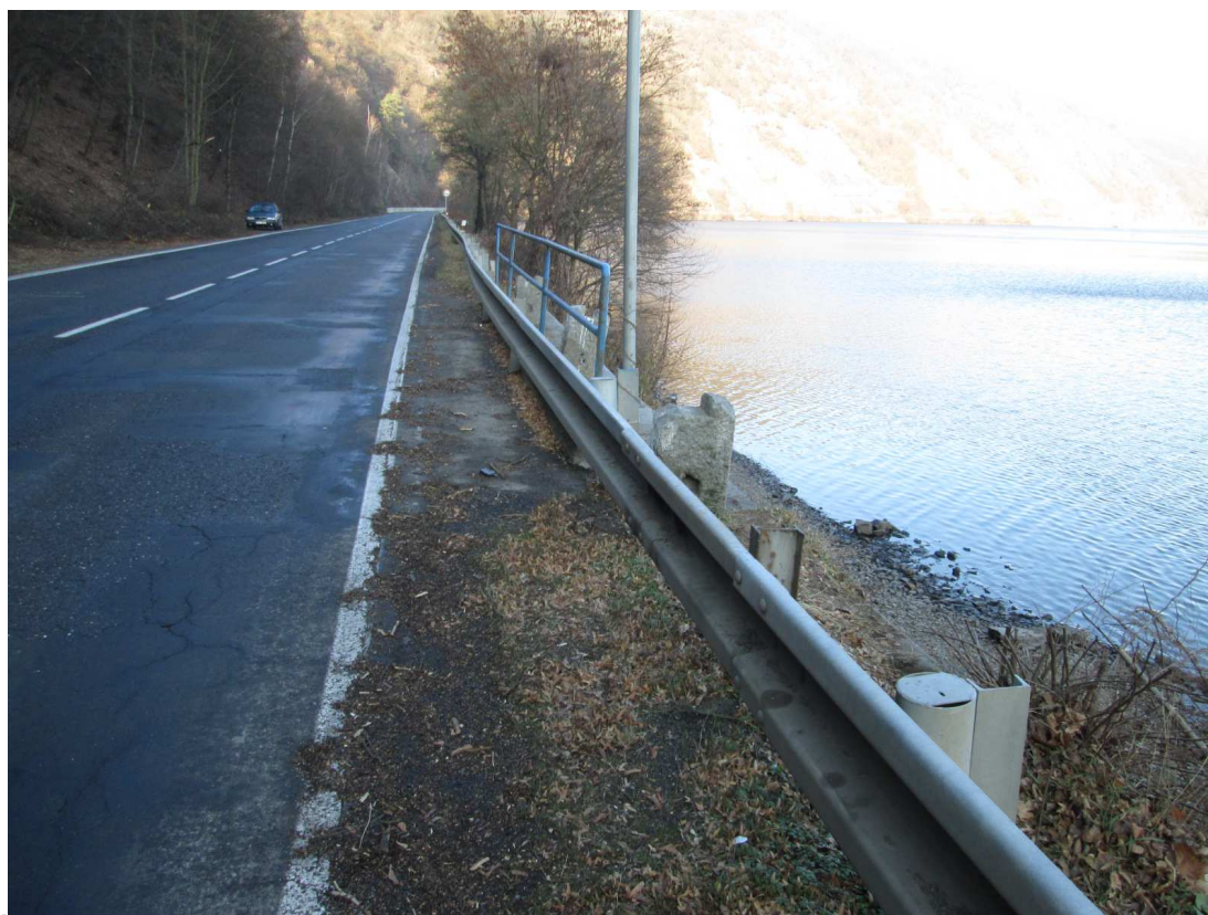
Pohled proti směru staničení. Nevyhovující záchytný systém.
