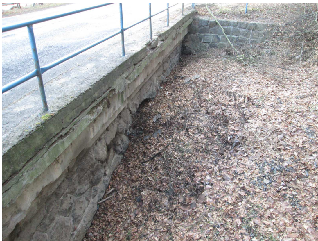
Pohled zprava. Římsa přibetonovaná. Degradace betonu římsy.
